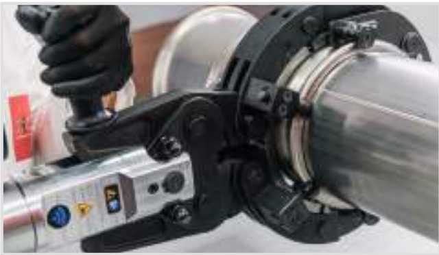
Assemblaggio pressatura n°2 / Press assembly phase 2
